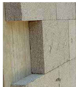
Isolamento termico "a cappotto"
